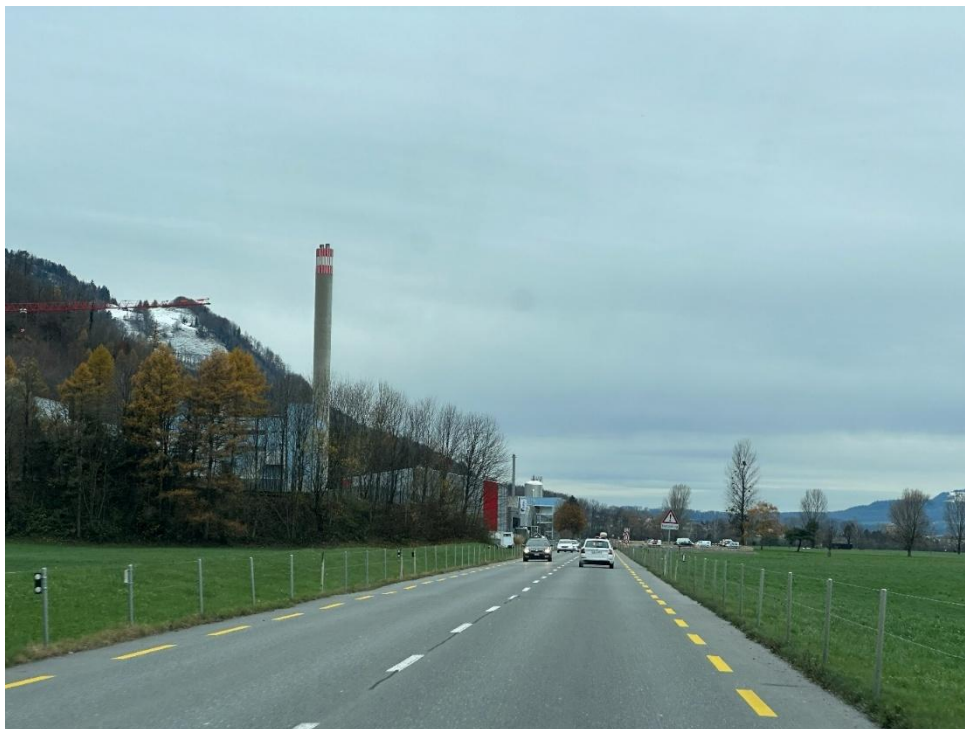
Abbildung 6: KVA Linth und Umgebung, mit Blickrichtung von Niederurnen.
